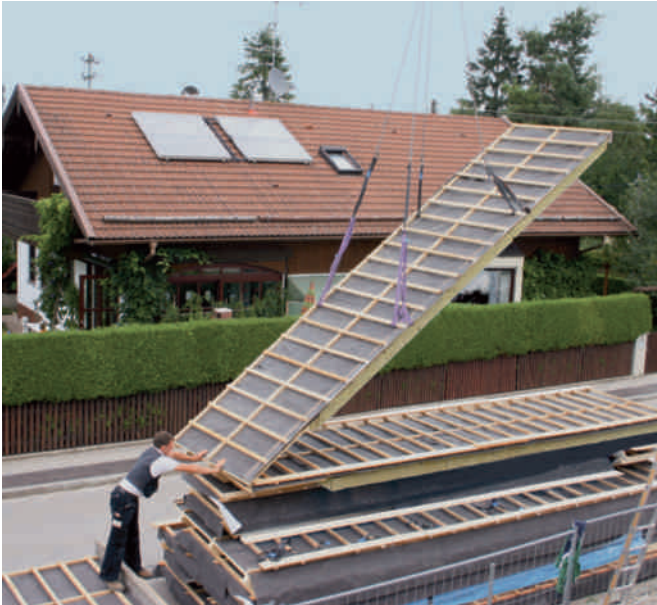
Termingerechte Lieferung an die Baustelle.
