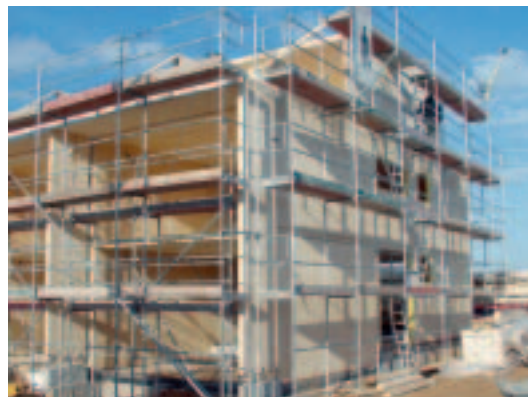
Rohbau Reihenhäuser in Darmstadt
