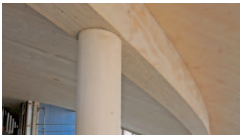
Zweifach gekrümmte Kerto-Platte
