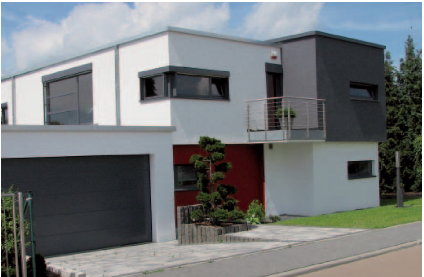
Wohnhaus in Idstein-Walsdorf
