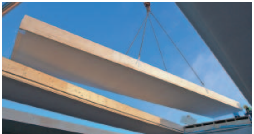
Dachelemente bis zu 23 m Spannweite
