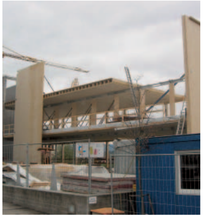
Hohlkasten-Deckenelemente, Fachhochschule in Salzburg
