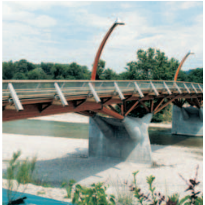
Straßenbrücke in Frankreich
