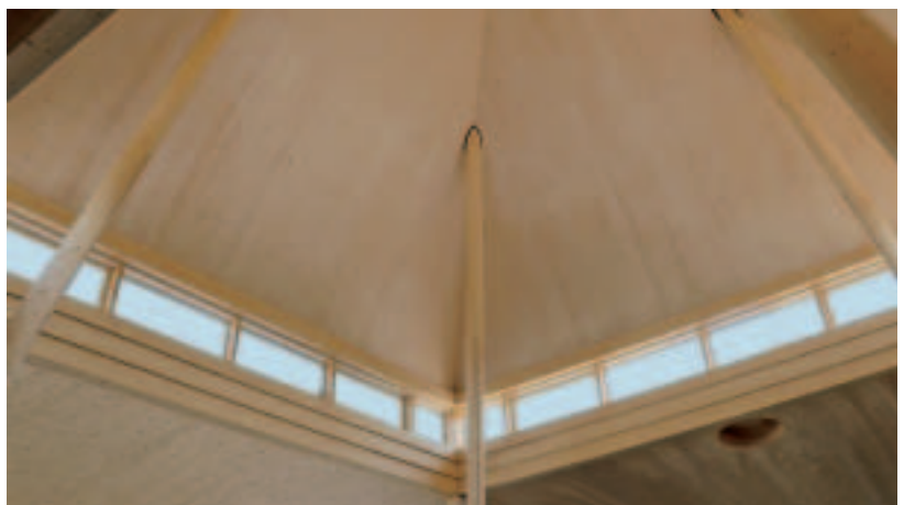
Gebogene Leno-Brettsper Holz-Elemente
