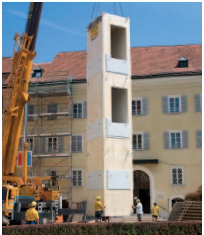
Aufzugschacht in Bad Reichenhall
