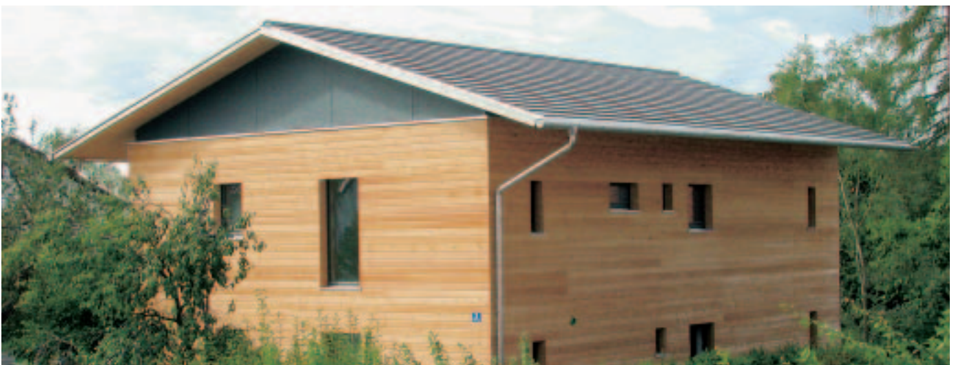
Wohnhaus im Passivhaus-Standard
