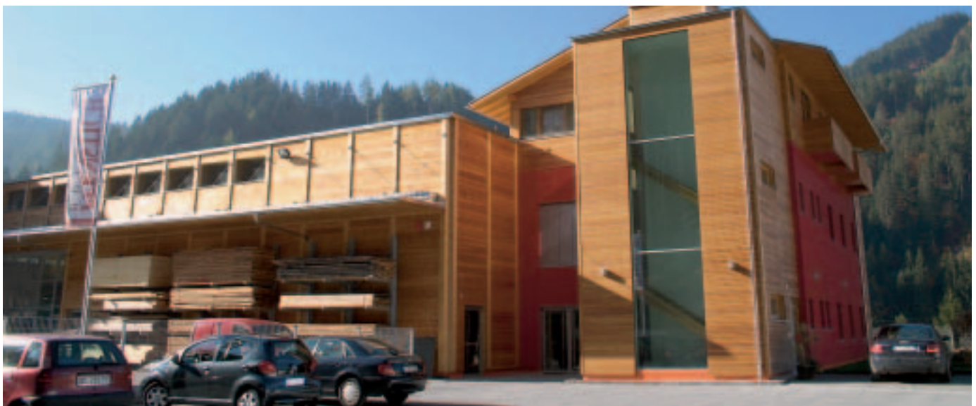
Industriehalle „Lignotec“ in Südtirol
