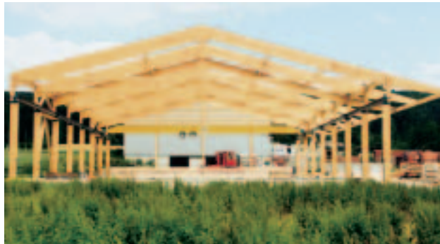
Kerto-Systemhalle mit Kranbahn und Satteldach in Lienen
