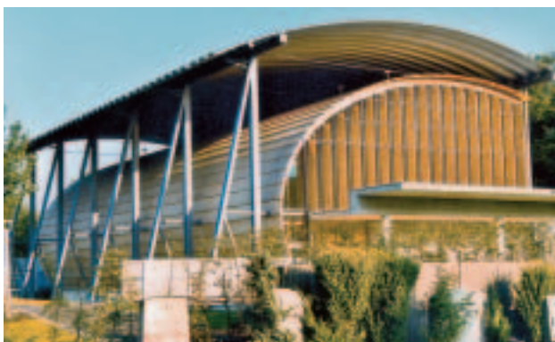
Aussegnungshalle aus imprägniertem Kerto in Gräffelfing
