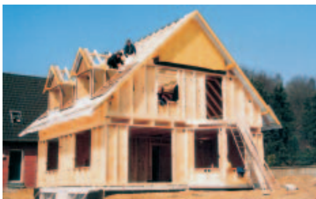
Wohnhaus in Holzrahmenbauweise
