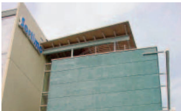
Kerto-Fassade „Sortimo“ in Zusmarshausen
