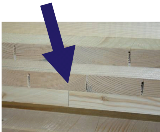
Abbildung 4: Stoß der Massivholzplatte
